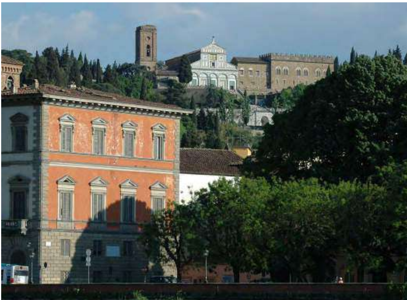
↑ Fig. 13 Aspetti corografici dell'Oltrarno alterati dal degrado cromatico e materico di Palazzo Serristori.
