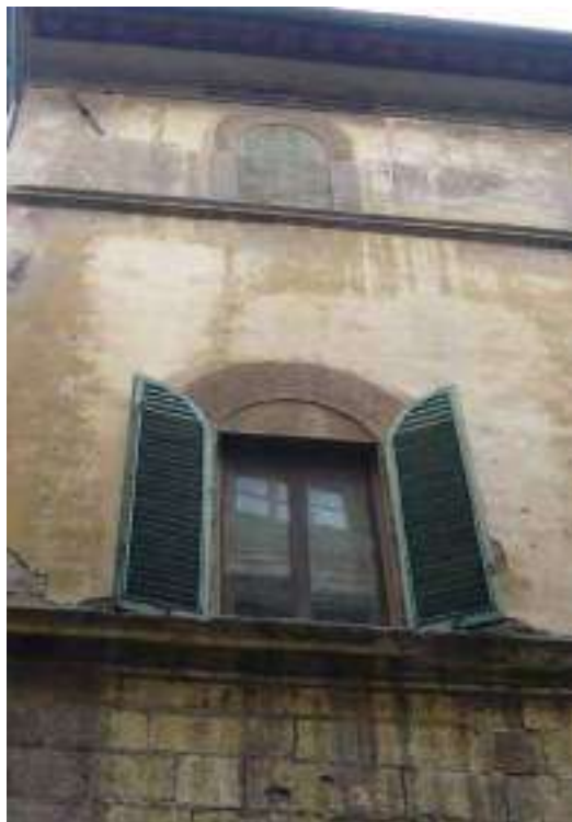
Figg. 11-12 Colori di fondo e vecchi intonaci degradati. Esempi di Matrice cromatica.
