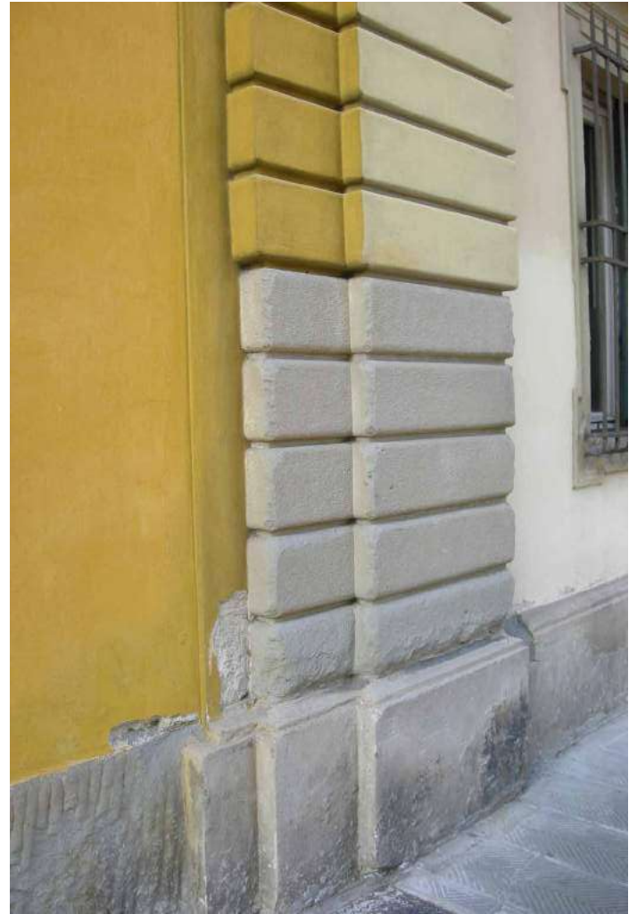
Fig. 5 Degrado e sgrammaticature cromatiche su edificio in Via del Giglio.
