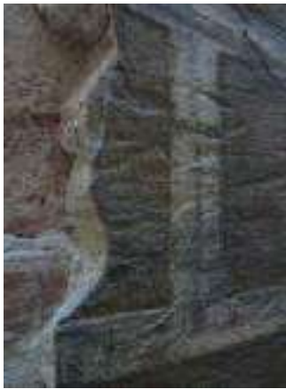
Fig. 10 Stratigrafia di un graffito: arriccio (strato chiaro verso il muro); intonaco (strato ruvido grigio scuro); finitura a calce (scialbatura bianca superficiale).
